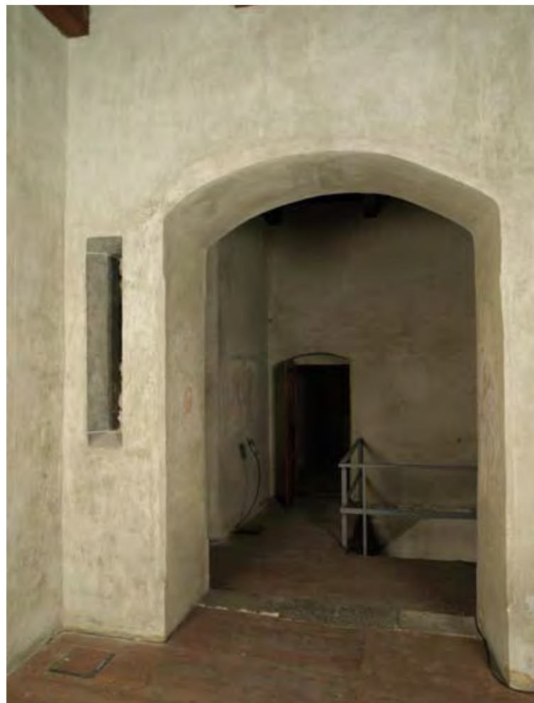
30. Traccia di una finestra tagliata dalla costruzione dell'arcata.
