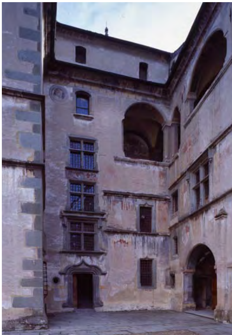
24. Cortile del castello. Veduta della parete con l'accesso al viret in cui risultano leggibili i diversi marcapiani.
