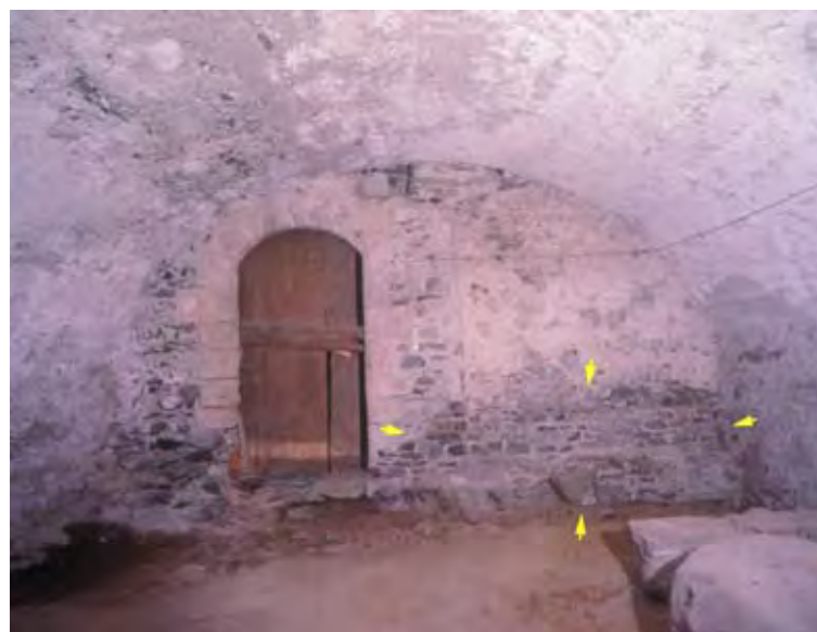
10. Indagine archeologica nei vani cantinati del castello con individuazione di alcune porzioni di un muro di epoca romana. Lato occidentale della domus episcopalis.
