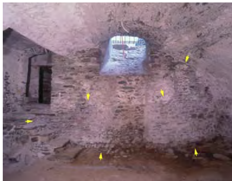
8. Indagine archeologica nei vani cantinati del castello con individuazione di alcune porzioni di un muro di epoca romana. Angolo sud-occidentale della domus episcopalis .
