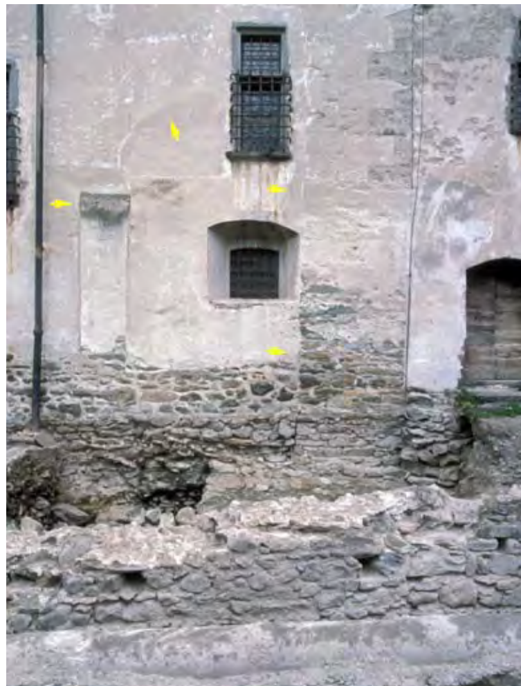
18. Fronte est del castello con le tracce dell'antico arco d'ingresso e dell'imposta dell'arco del primo ingresso.
